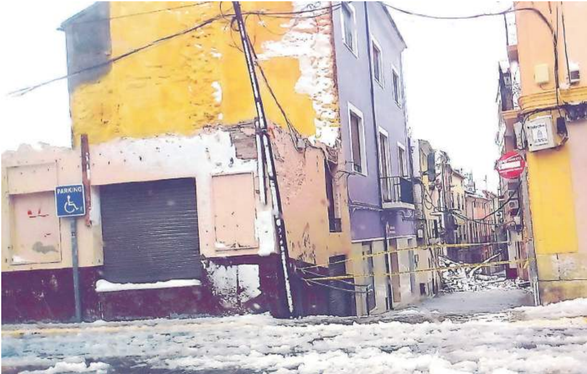
Uno de los destrozos fue el derrumbe de una vivienda en la calle Empedrat
